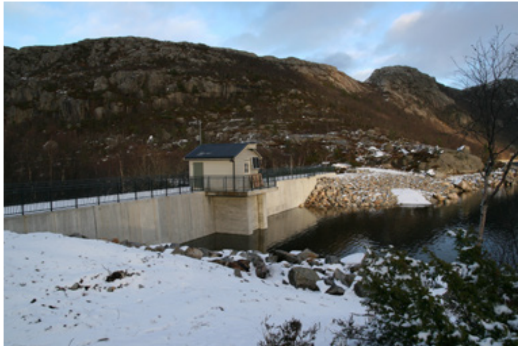
Den nye dammen på Svortingsvatn kan ikke passeres ved overløp. NVE vil ikke pålegge regulanten å bygge en ny kryssingsmulighet ved dammen. Foto: Ove S. Førland.
