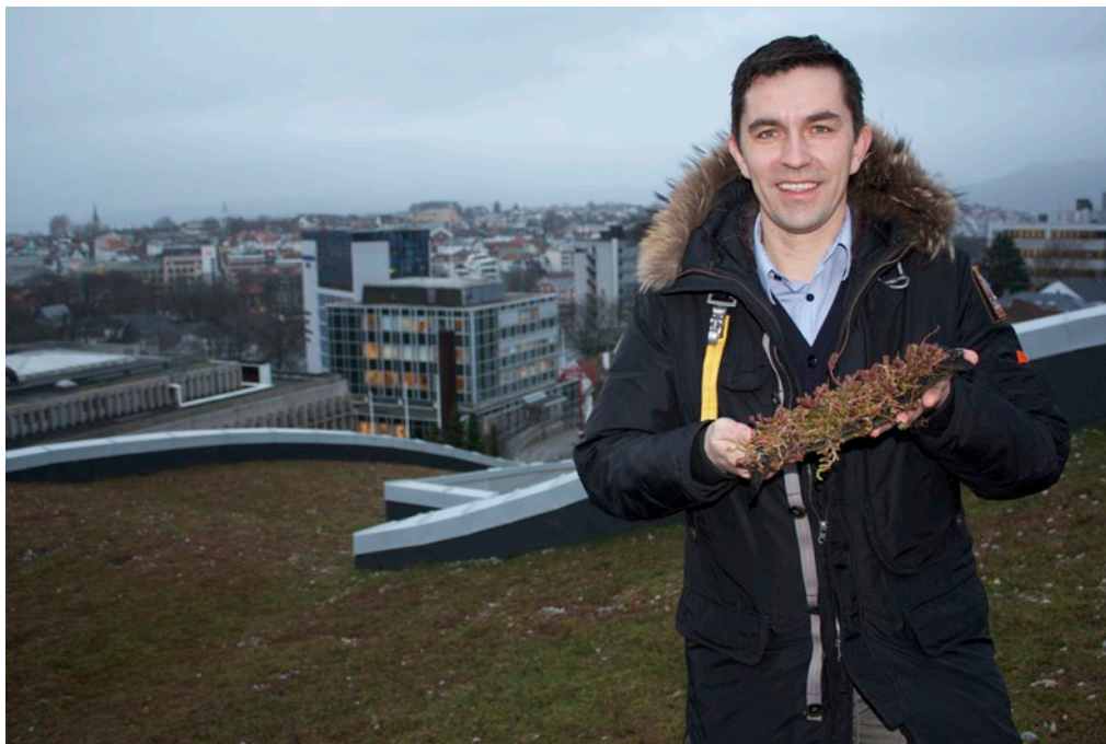
Det nye Comfort Hotel Square i Stavanger, har sedumtak. Sedumplantene vokser på matter som den Bengt Tovslid holder i hånden.
