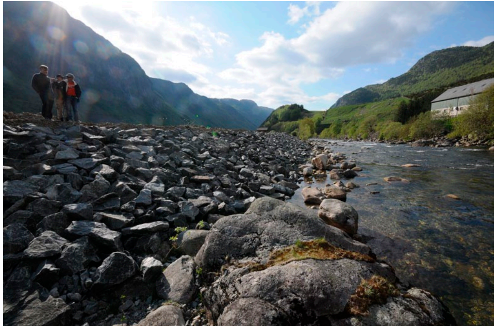
Over en strekning på ca 100 meter består elvebredden av en stor fylling med sprengstein. Steinen går ut i elva og det meste av fyllingen ligger i flomsone.
