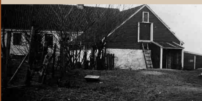
VÅNINGSHUSET OG FJØS/LØE SETT FRA SØR-ØST. FRA SLUTTEN AV 1940-TALLET.
