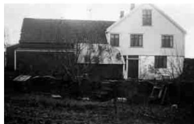
VÅNINGSHUSET OG LØA SETT FRA HAVNEHAGEN I NORD. FORAN TIL VENSTRE GRISHUSET, OG DERETTER GJØDSELBINGEN. FRA SLUTTEN AV 1940-TALLET.
