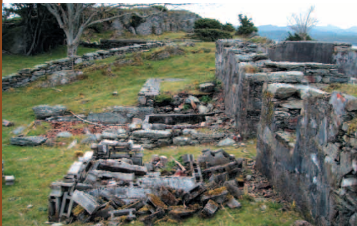
SLIK SER DET UT I DAG: RESTENE AV VÅNINGSHUS OG LØE TIL HØYRE. FORAN RESTENE AV AGGREGATHUSET, DERETTER GJØDSELBINGEN OG BAK GRUNNMUREN TIL GRISHUSET. TUNTREET STÅR VED STEINGJERDET I HAVNEHAGEN OG HELT BAKERST SKIMTES GOLVET TIL KARANTENESTASJONEN.
