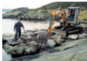
BRYGGA, NAUSTTUFTEN, STEINGJERDER OG DRIFTEVEGEN BLE REPARERT VINTEREN 2003. LARS HEBNES (TV) OG ARILD LERANG BAK SPAKENE.
