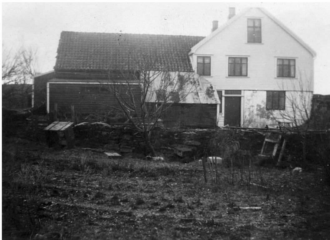
Figur 20 Gården sett fra nord. Løa bygd sammen med våningshuset. Foran t.v. grishus og deretter møkkabingen (blikktak). Bildet er fra slutten av 1940-tallet.
