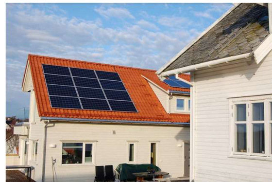
Utenpåliggende solcellepanel. Foto: Solabladet
