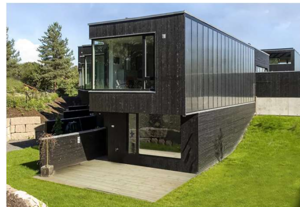
Solfangere i fasade. Foto: Inaventa Solar
