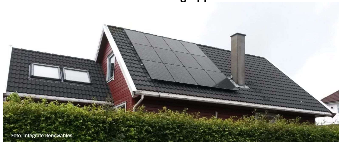
Utenpåliggende solcellepanel. Foto: Solabladet
