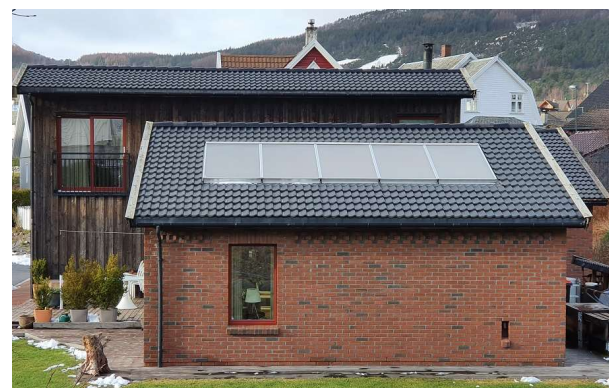
Solfangere på skråtak. Foto: Rune Folkvord
