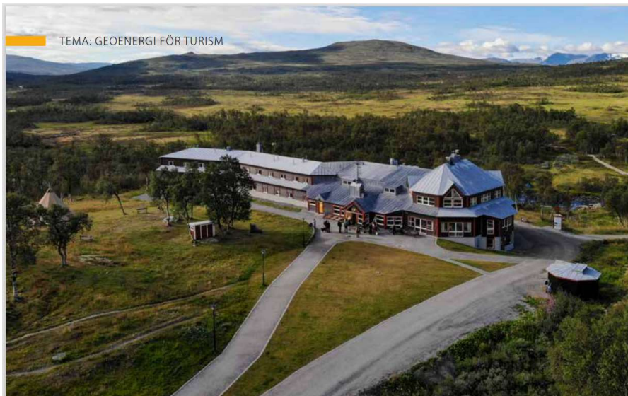
STF Storulvåns Fjällstation har en geoenergianläggning som stöttas av en oljepanna som spets. Foto: Henrik Rollstedt.
