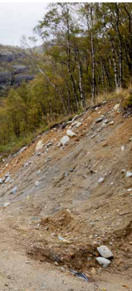
Ved bygging av enkel traktorveg skal vegen tilpasses terrenget. Da skal man gå rundt fjellet og ikke spreng seg gjennom som ved Helgaland.
