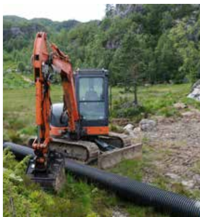
Lovligheten av Hovdestølvegen i Hamrabø er ikke endelig avgjort. Likevel fortsetter byggingen.
