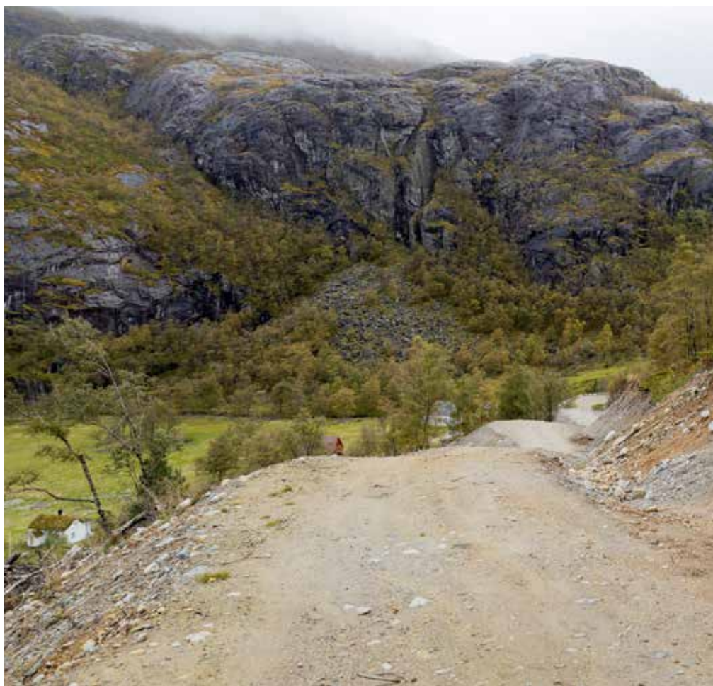
Massivt inngrep i vakkert kulturlandskap ved den fraflytta gården Helgaland i Hjelmeland.
