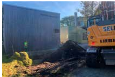
Når du leser Rygjavern er vi forhåpentlig i gang med å fylle byggegroppen med grunnmur og reisverk. Foto: Erik Thoring
