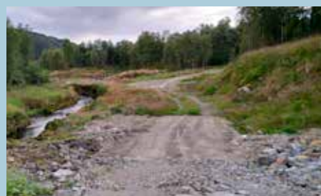
Omfattende graving og fjerning av kantvegetasjon nedstrøms Teksevatn.
