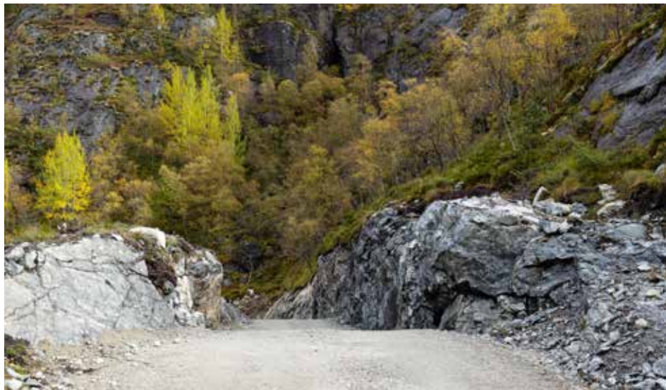
Ved bygging av enkel traktorveg skal vegen tilpasses terrenget. Da skal man gå rundt fjellet og ikke spreng seg gjennom som ved Helgaland.
