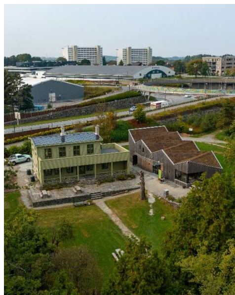
Mostun-renoveringen ferdig i oktober 2021. Foto: Espen Mills
